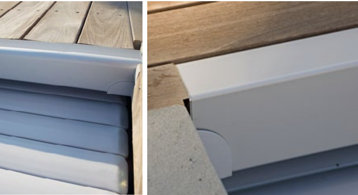
Exemple de montage bien ajusté Fitted assembly example
